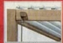
Mécanisme d'orientation des lames
